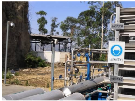
气化区可燃气体监测探头
