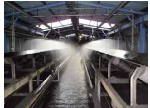
当温度警报被触发时,PLC立即停止了传送带的运行并激活自动喷水灭火系统。
