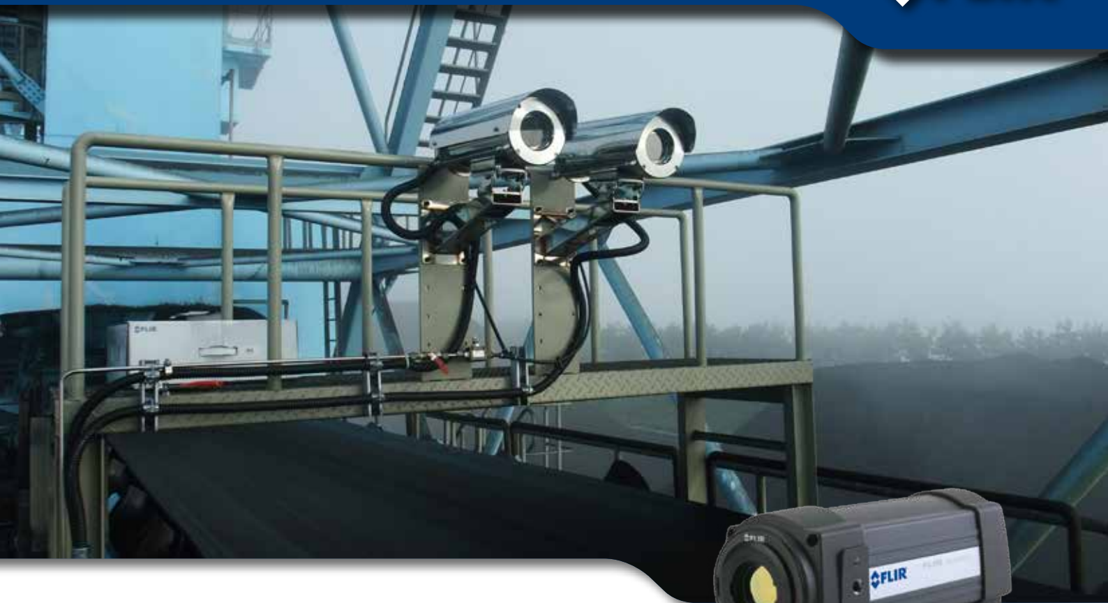
FLIR A310红外热像仪安装在输煤皮带上方的防护外壳内。
