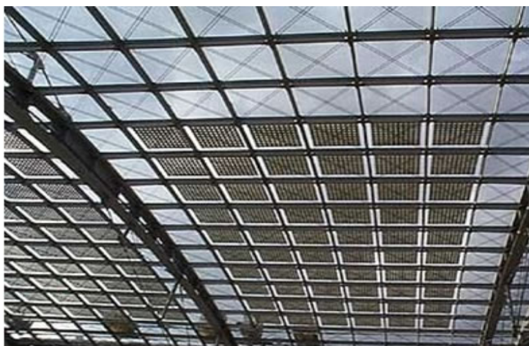
图 2：美国 stillwell 地铁站光电屋面工程，非晶硅太阳能电池面积 50,000 平方英尺。发电峰值功率为 250 千瓦
