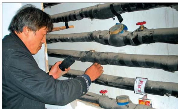
热力工作人员在检修供热管道。
