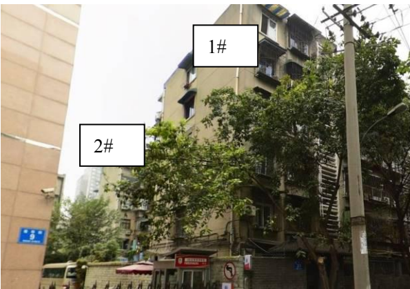
项目西面紧邻 1#、2#楼现状
