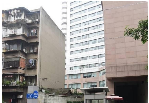
项目西面紧邻 3#楼现状
