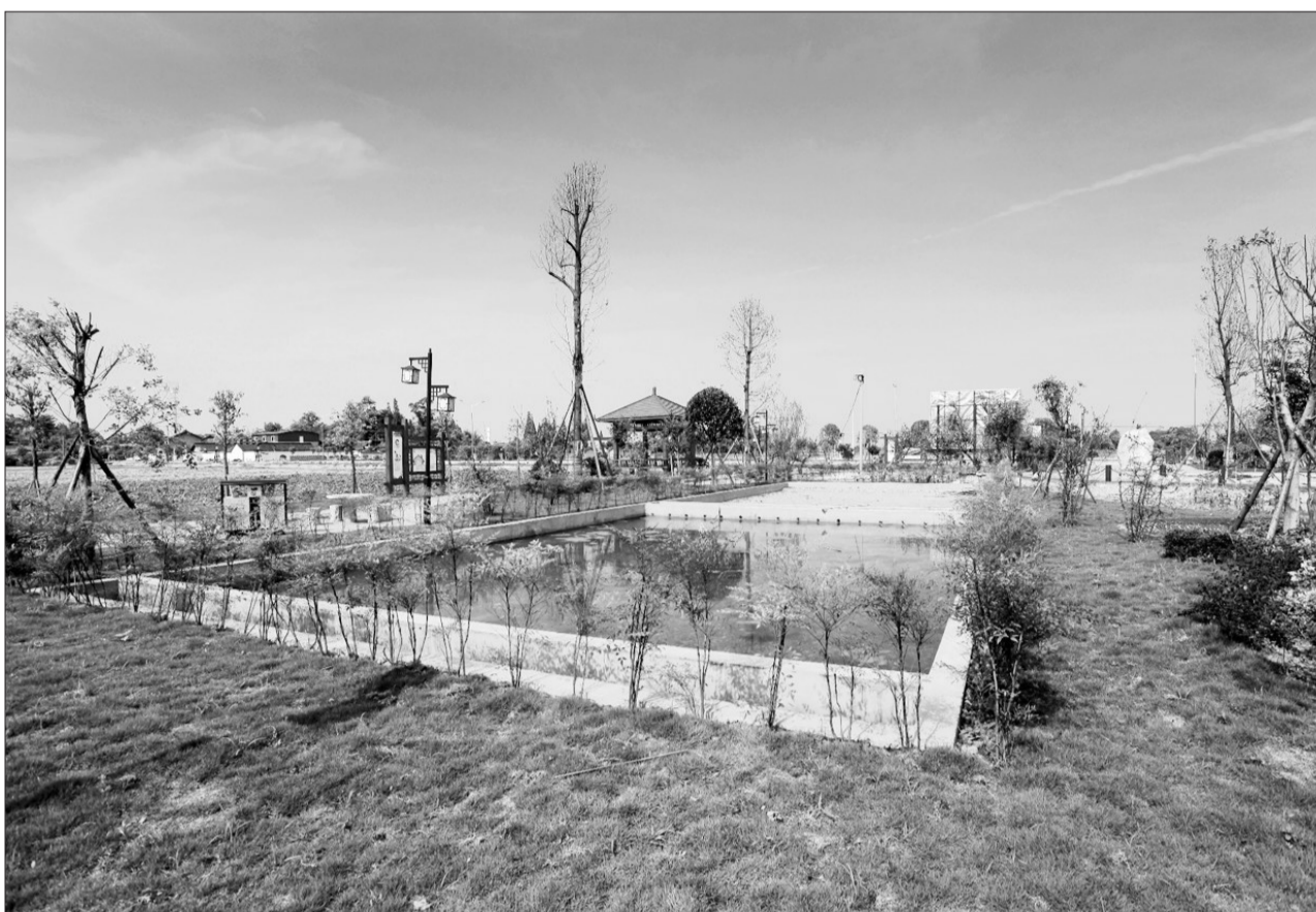
图为广汉市金轮镇污水处理站。
