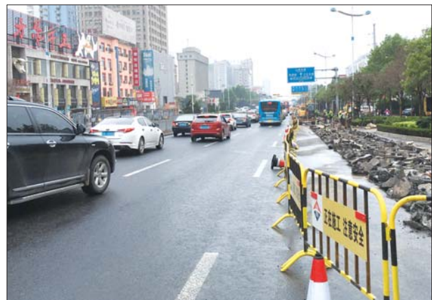
正在施工的经十路。 本报记者 王皇 摄
