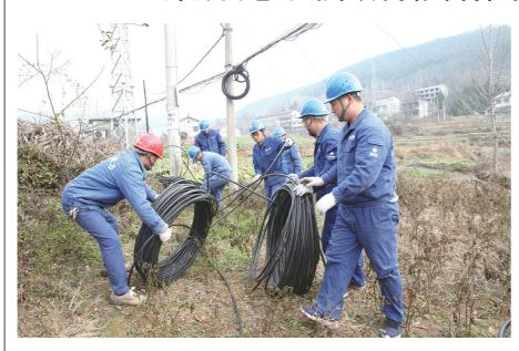
12月13日,在官渡镇水 田坝村的城隍庙,国网质 市供电公司官渡供电所员工 对10千伏官魏线开展集中 缺工作,通过"一停多用、集 中作业"的方式,为线路进了 检修"保养",高效完成路 次检修任务,消除了线路 患,确保了电网的可靠运行。
