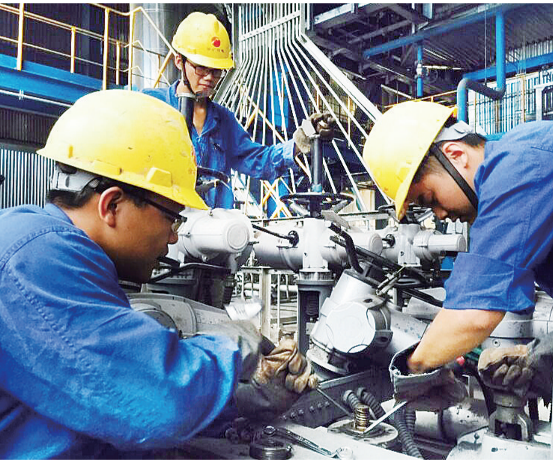
“迎峰度夏”期间,为保证双机组安全运行,阿克苏热电公司生产运行部机务班人员冒着高温盯在现场,随时掌控锅炉水温。图为该班人员在检修减温水阀门,保证气体正常降温,以防温度过高引发锅炉爆管现象发生。
