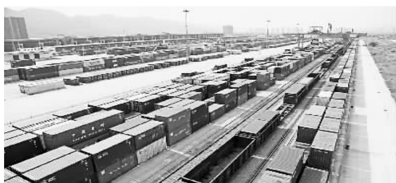
重庆市沙坪坝区团结村铁路集装箱中心。
