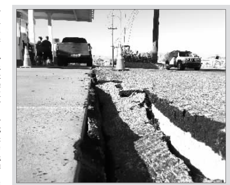
7月6日,在美国加利福尼亚州小镇特罗纳,道路在地震中受损。
