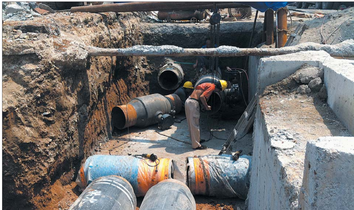
和平路西口,施工人员正在铺设供热管道。(资料片) 本报记者 陈玮 摄
