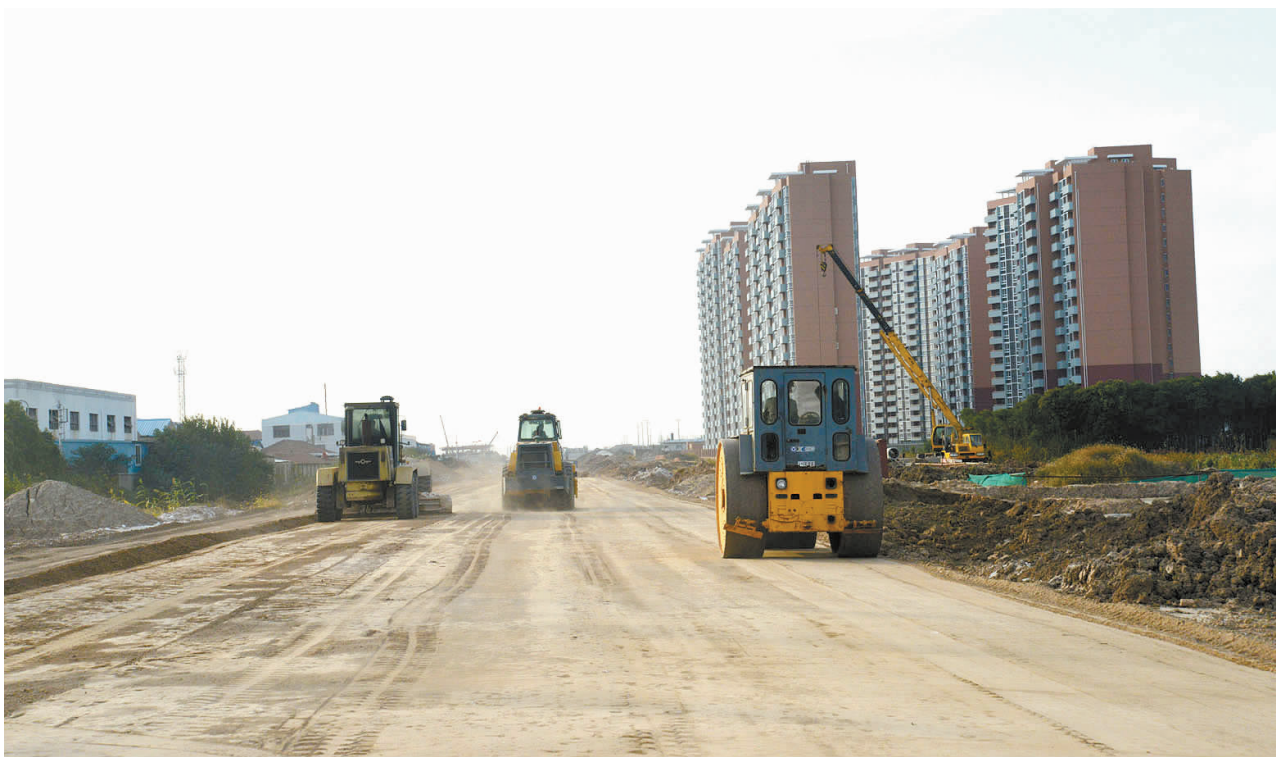
10月27日下午,世纪大道西延工程现场,3台压路机进行路基压实施工。该路段东起江海路西至西苑路,全长3700米,路面宽60米,预计年内竣工。近年来,我市市政路网不断完善,道路建设重点将由“通”向“连”转变,打通环线、南进东拓,着力构建更加通畅的出行环境。 潘杨摄
