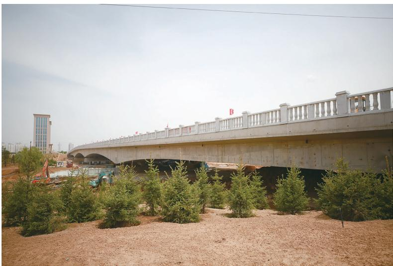
2015年10月份开工建设的平安大桥总投资8300多万。目前,桥梁主体和附属工程全部完工,正在铺筑桥面沥青混凝土,预计6月底铺筑完毕。
