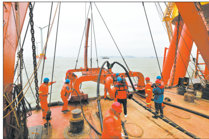
3月31日下午,一条长520米、直径12公分的35千伏输电海缆顺利登陆浙江普陀6号海上风电项目,六横海上风电项目最后一根海缆敷设完成,经过调试后将在4月5日前全部投运。普陀6号海上风电场总装机容量为252MW,全部投产后,预计年上网电量7.53亿千瓦时,每年可节约标煤24万吨。
