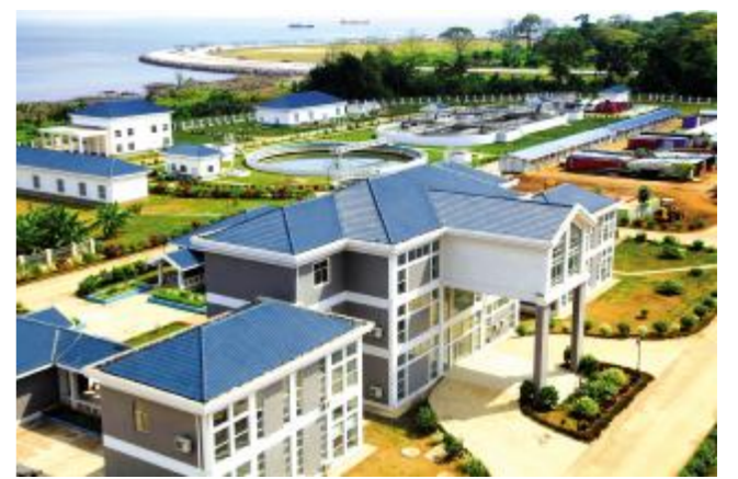
赤道几内亚马拉博污水处理工程
