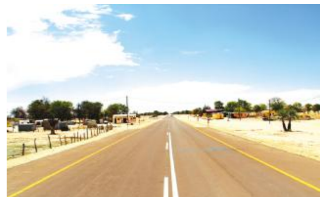
纳米比亚北方公路升级改造项目
