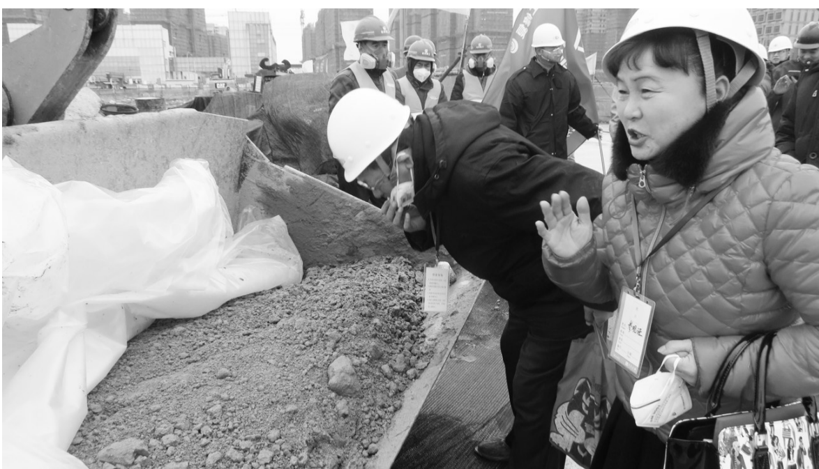
图为市民代表参观土壤污染治理施工现场。
