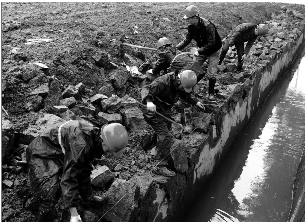
浙江省武义县白鹭溪综合整治、坦洪乡农村生活污水治理等43个治水项目日前同时开工。这些治水项目,涉及全县19个乡镇、街道、工业区和温泉度假区,有河道治理、防洪堤加固、生活污水治理等,首批开工的43个治水项目总投资额达55172.47万元。 中国日报图片网供图
