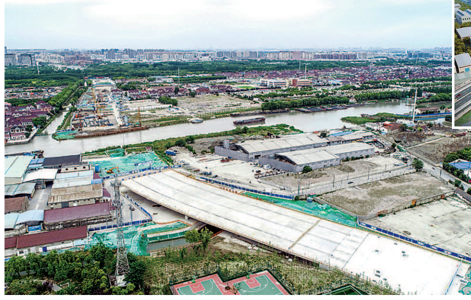
大桥南引桥浇筑完成。
