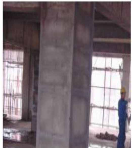
外包钢抹浆防护
