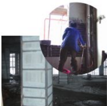
湿式外包钢注胶施工
