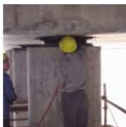
注胶加固级更新桥梁支座
