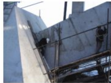
桥梁灌注粘钢加固
