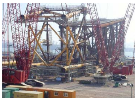
番禺 30-1 导管架上部框架扣片
