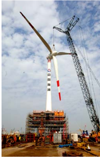
正在塘沽场地建造的渤海风力发电项目
