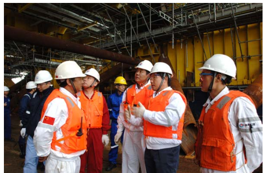
姜锡肇总裁等公司领导亲临 BZ34-1CEP 组块施工现场
