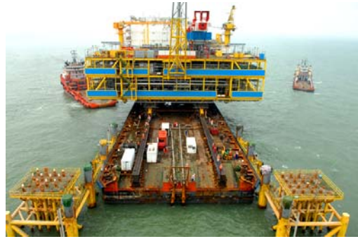
浮托法安装 BZ34-1CEPA 组块
