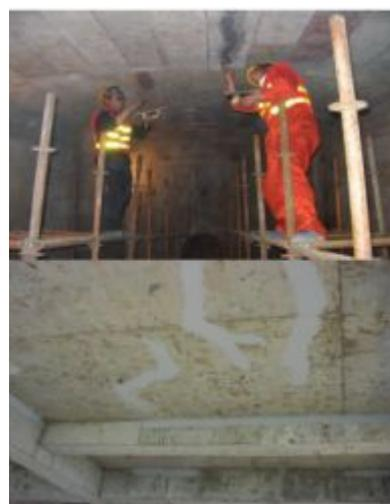
封闭混凝土微裂缝
