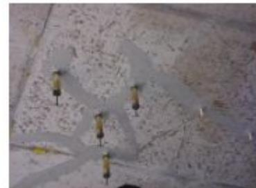
封闭裂缝表面及粘贴注胶座
