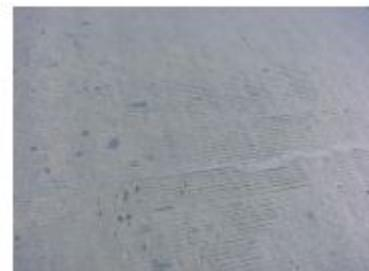
裂缝扩缝后表面封闭
