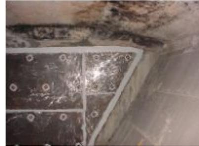
灌注施工中密封混凝土与钢板缝隙
