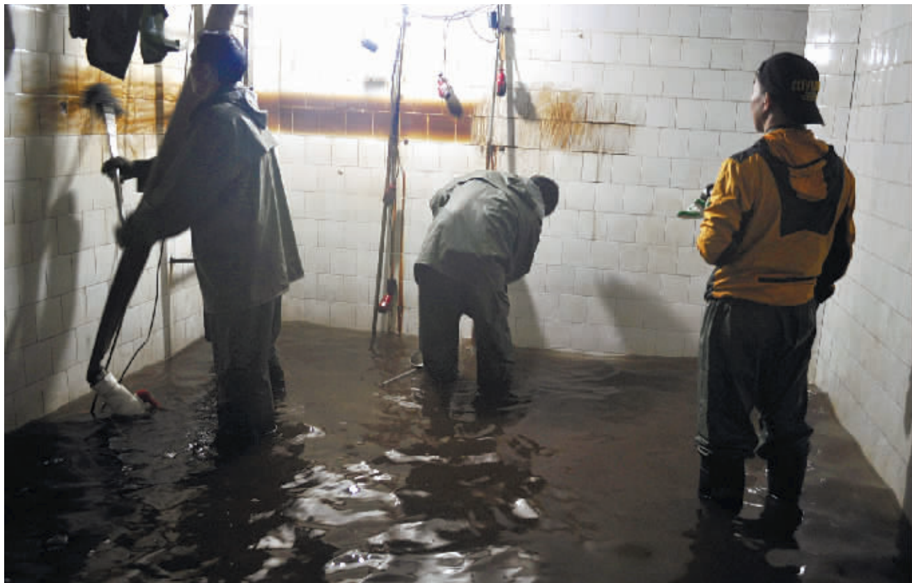
4月20日,长沙市金邮小区,一名志愿者全程观看小区水池清洗过程,池底的污水已没过膝盖。
