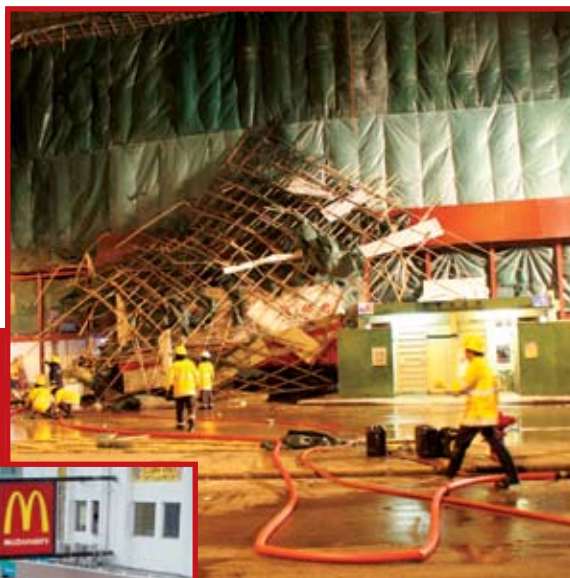
消防人員在香港仔倒塌外牆瓦礫中搜索傷者 (消防安全大使李少海圖片) Firemen search for victims through the wreckage of a wall collapse in Aberdeen (FSA Rickie Li photo)
