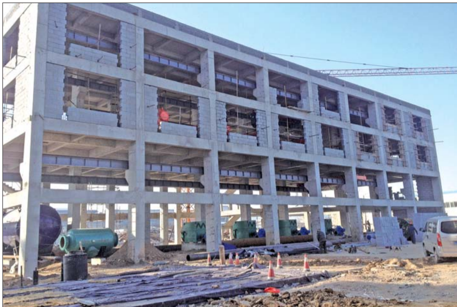
建设中的兴阳热源厂首站。 本报记者 梁越 摄
