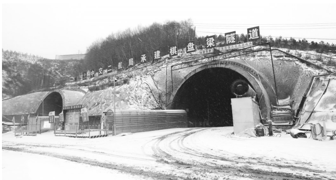
中交二航局承建的棋盘梁隧道施工现场
