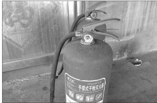
两个布满灰尘的过期灭火器。
