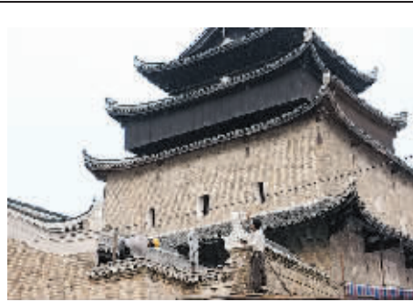
10月26日，建筑工人在江永县“千年古村”上甘棠村修复文昌阁附属建筑。近年来，该县大力实施“旅游旺县”战略，突出生态旅游，加强旅游基础设施建设。 潘百万 摄
