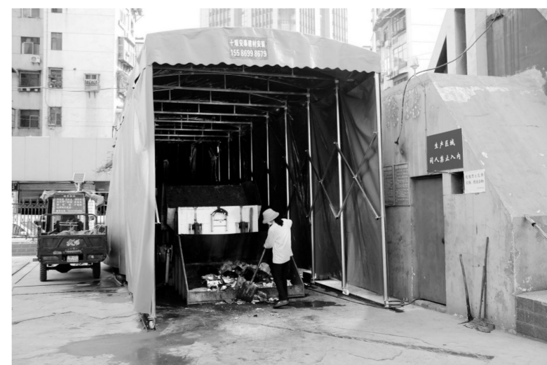
在湖北省十堰市燕林小区垃圾中转站封闭式大棚里,一台自动垃圾中转箱正在进行装载垃圾作业。在这之前,燕林小区垃圾中转站为敞开式垃圾站,环境脏乱和臭气严重影响周边居民生活。为改变这一状况,十堰街办在燕林小区垃圾中转站上面安装半封闭式装置。这个可伸缩大棚采用帆布和钢结构搭建,在装载垃圾作业时,可有效减少扬尘和垃圾二次污染,效果得到附近居民的认同。薛乐生摄
