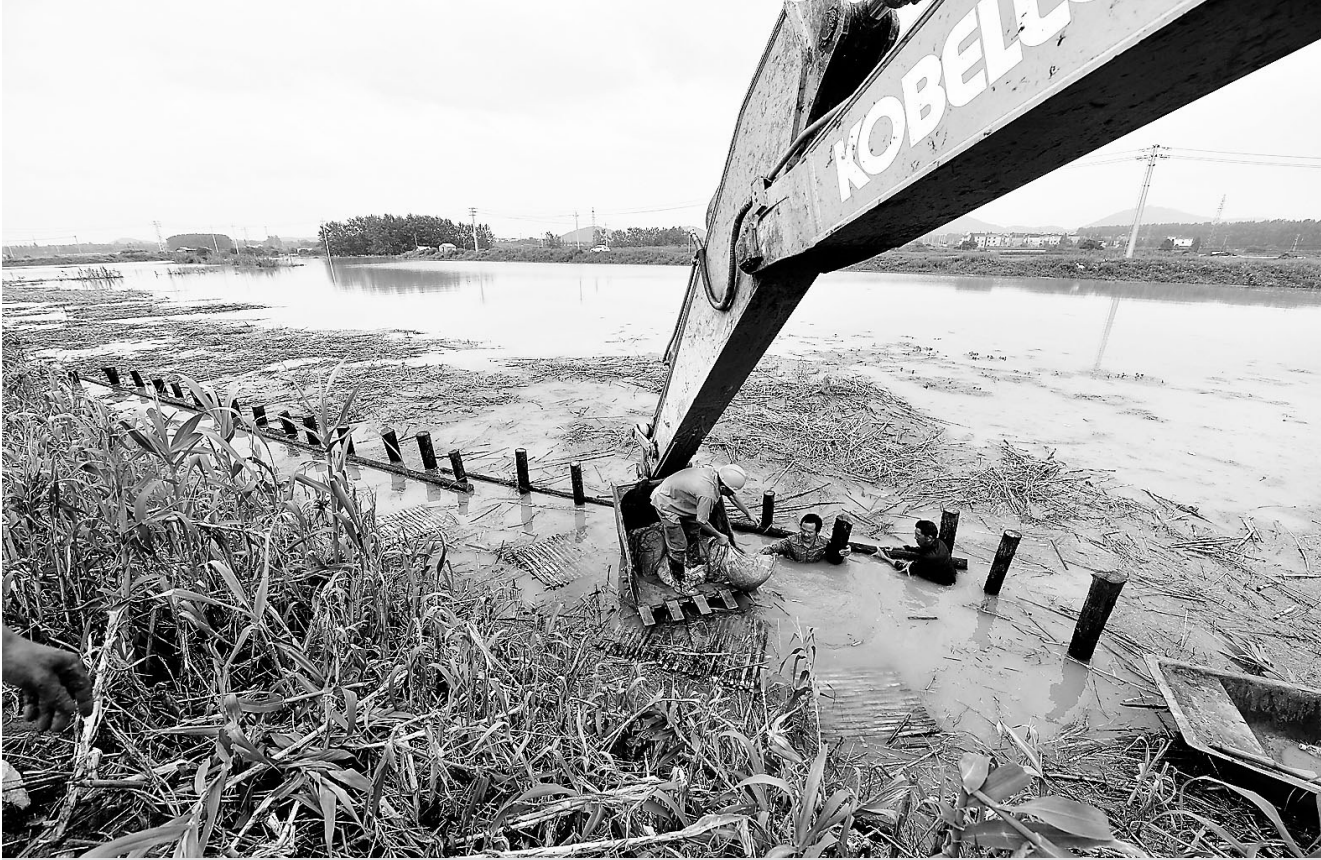
7月4日,在江苏南京溧水区和凤镇西圩,抢险人员在加固一处渗水的河堤。 新华社记者 季春鹏 摄
