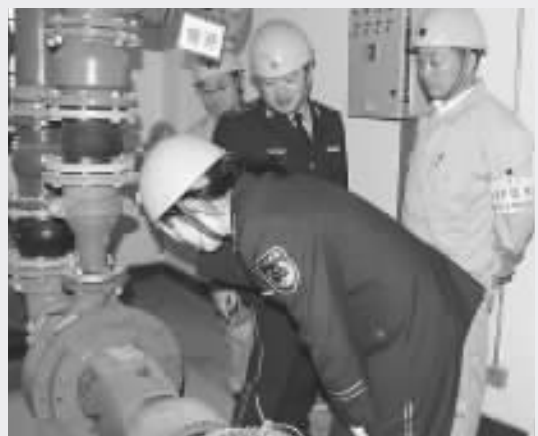
日前,宝江消防支队联合宝钢安监部等单位开展了辖区集体宿舍消防安全大检查。对于检查中发现的问题,要求相关单位、个人当场整改或下发责令限期整改通知书。图为检查人员在现场检查消防设施。刘纪增 摄
