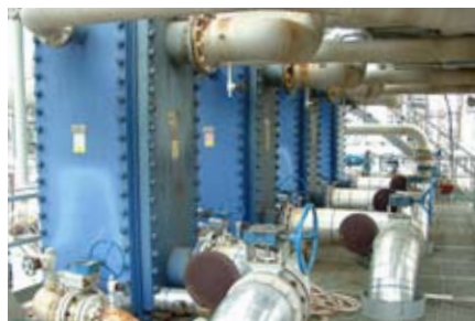
在萨尼亚精炼厂运行的阿法拉伐 Compabloc板式换热器
