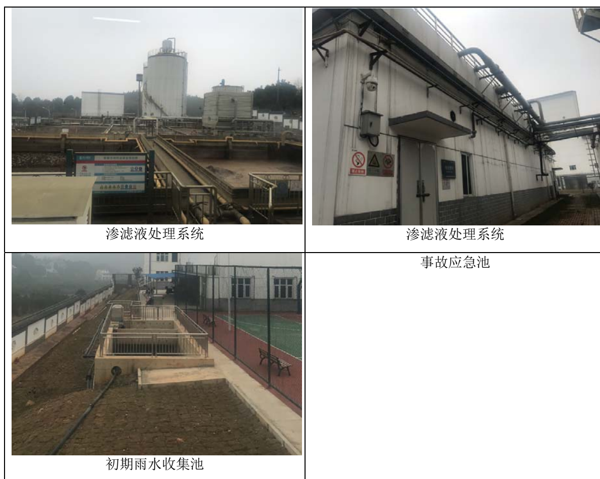
图 3.6-1 现有工程废水处理系统现场图片
