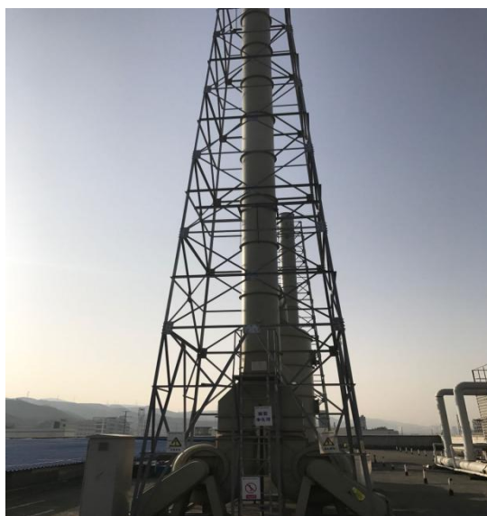
原有酸碱废气洗涤塔
