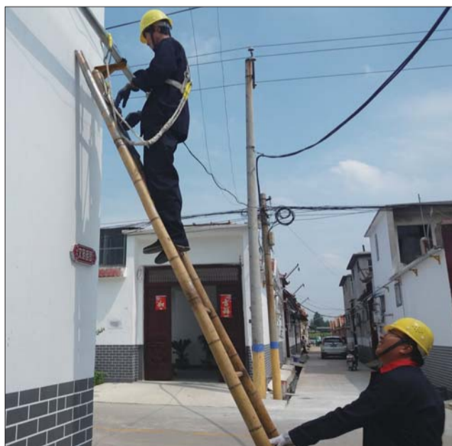
工作人员正在进行架空管作业。
