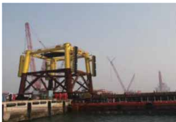
导管架滑移装船
