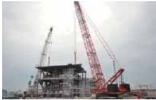
上部组块场地总装
