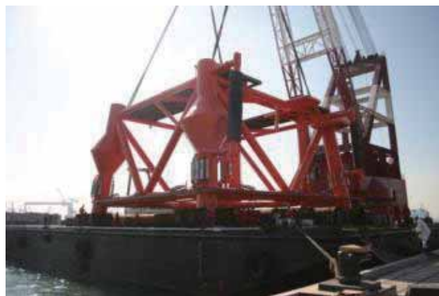
导管架吊装装船
