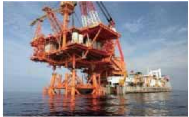
上部组块吊装安装
