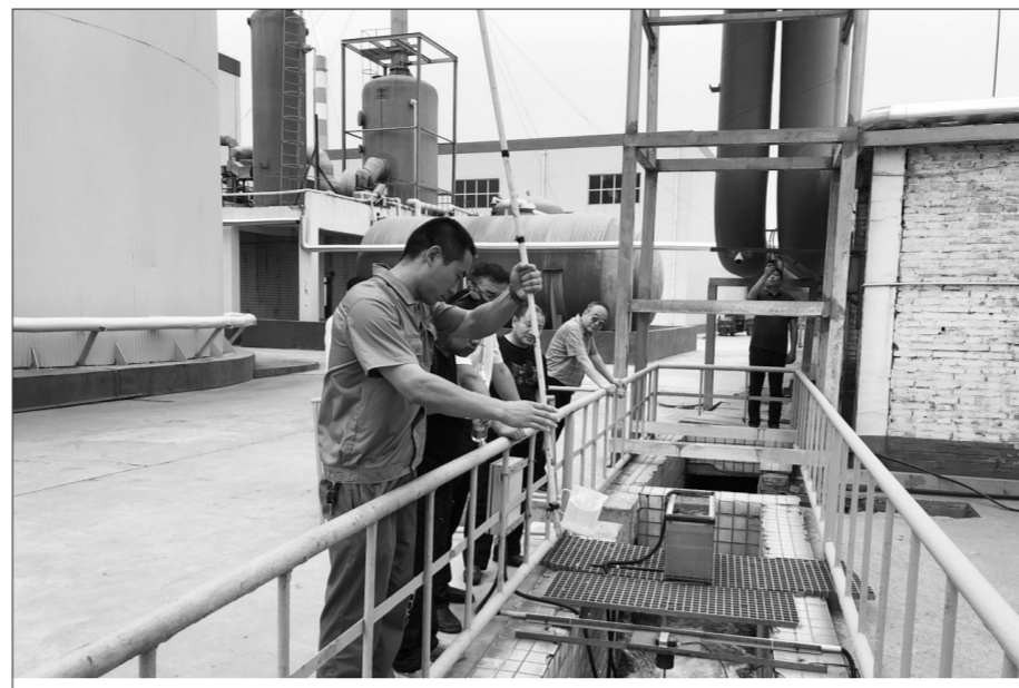
图为7月5日,执法人员在河北省邢台市晋县五峰实业集团有限公司污水处理站进行体检式执法检查。
