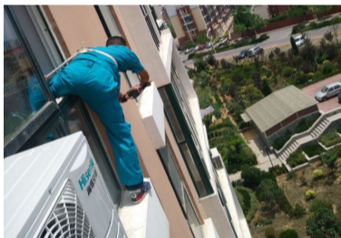
海信空调现场安装画面
