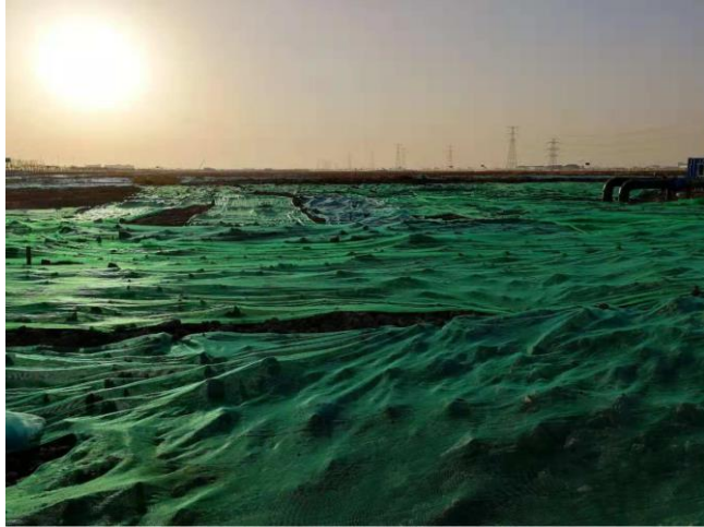
图 1-4 工程所在地现状照片
