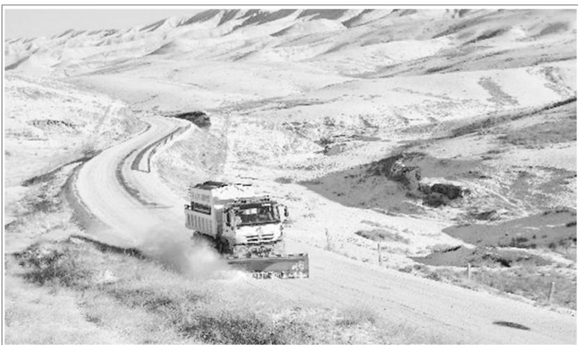
11月17日下午,肃南地区普遍出现降雪天气,导致省道213线和220线路段路面存在积雪。肃南公路管理段以雪为令,迅速启动清雪保通应急预案,对积雪路段展开清雪,撒布防滑料、融雪剂,重点对公路急弯、陡坡、桥梁等路段进行重点防滑措施。共出动养护职工20人、机械5辆,抛撒防滑料70立方、融雪剂10.5吨。 王振海 摄
