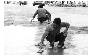
近年来,我县不断加大老旧小区改造力度,提升居民生活质量。图为工人正在对老旧小区路面进行改造。 记者 陶丽媛
