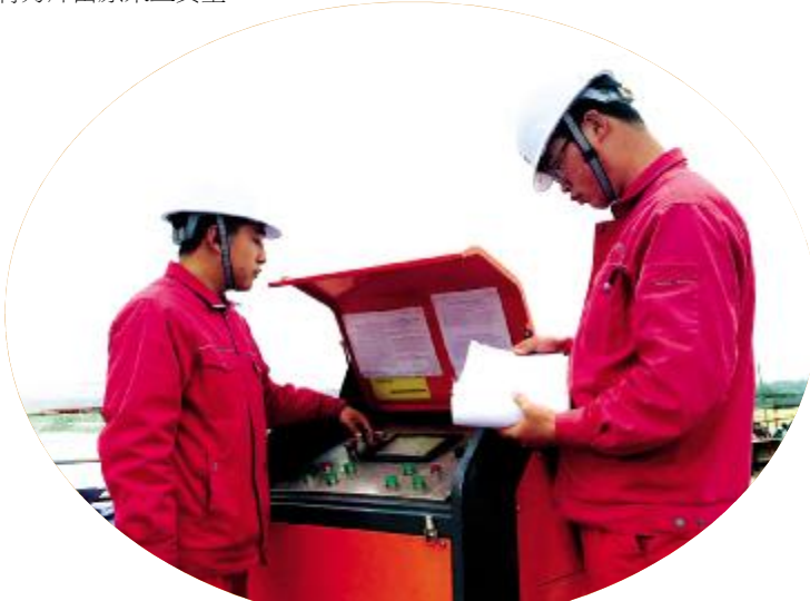
汉江特大桥主墩施工班组长(左)在施工现场
