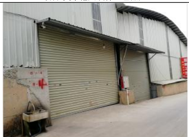
项目西侧-他人铁件工艺品厂
