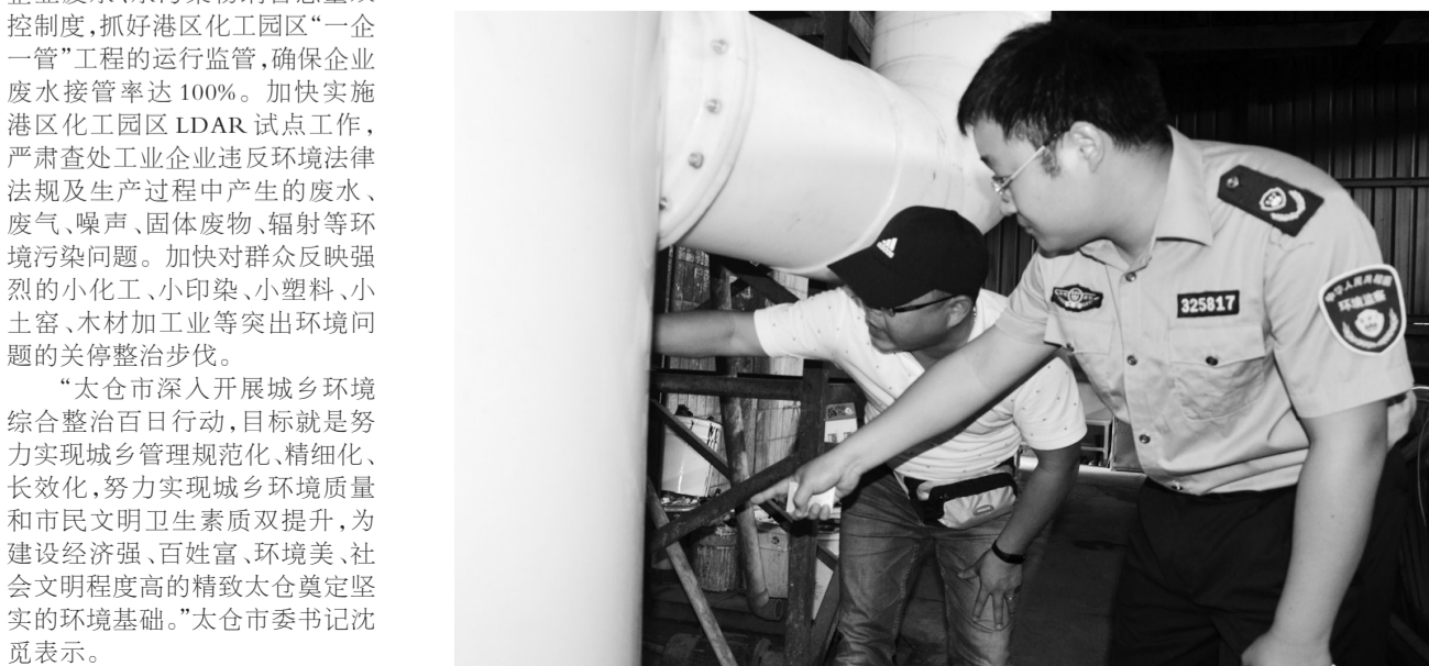
图为太仓市环境监察大队执法人员检查企业酸碱洗涤塔运行情况。
