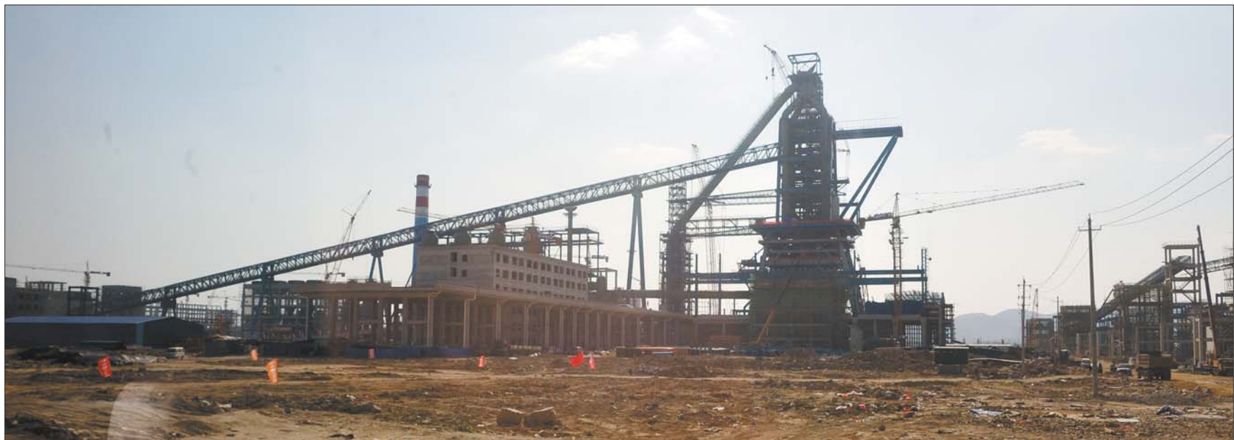
一号高炉主皮带长廊顺利完工。本报记者 张中 摄
