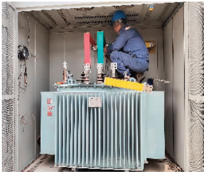
13日上午, 市供电局的工作人员对损坏的变压器进行抢修。记者刘净伶 摄
