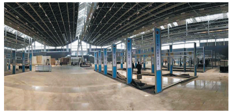
河北省石家庄国际会展中心的所有展厅实现了“全无柱设计”。(资料图片)
