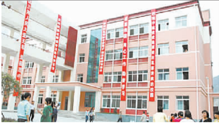
我省援建的四川理县中学教学大楼。(资料图片)
