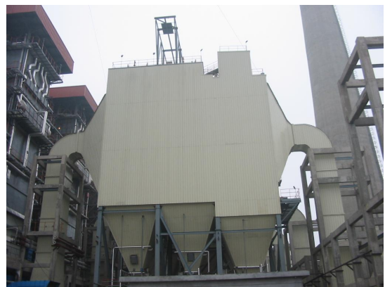
▲这是3电场型(3个电场构成的除尘器), 左侧(入口侧)2个电场是固定电极型、右侧 第1个电场是移动电极静电除尘器(锅炉废 气从左向右流动)。
