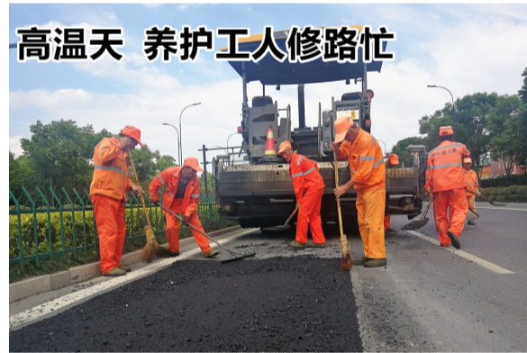
高温天气是公路施工的黄金时期。连日来,临安公路段公路养护人员加紧对S102省道青山段路面坑洞进行修补作业。
